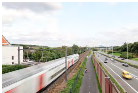
Afb. 1 Bundel van bypass infrastructuur
