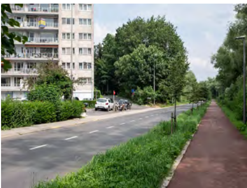
Afb. 5 Fietspad langsheen de Molenbeek takt niet aan op sociale woontoren
