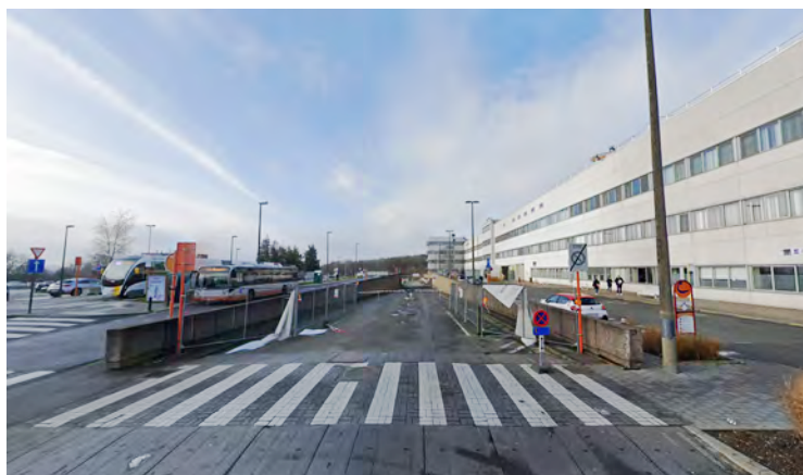
Afb. 33 Tunnel aan de spoedafdeling van het UZ
