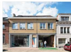
Zorgzame verbouwing van een fabriek tot opvang voor dak- en thuislozen CAW Oost-Vlaanderen vzw - De Blekens
