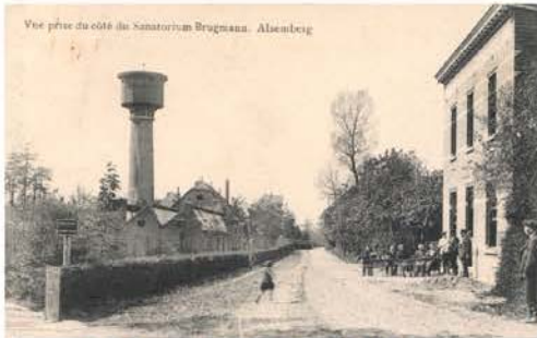
Watertoren uit 1909, afgebroken in 1950
