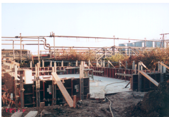
foto's uitvoering ketelhuis
