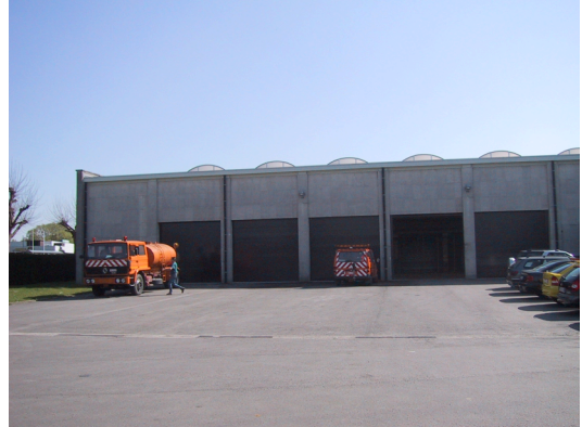
foto bestaande toestand: uniforme gevel
