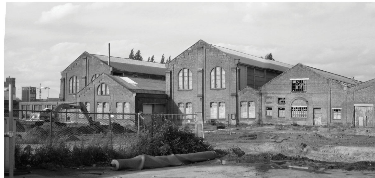
Gevel zuid, bestaande toestand
