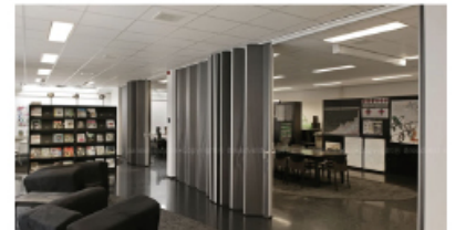
schakelsysteem klasclusters: vouw wand systeem
