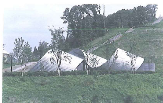
Voorbeeld van eenvoudige ingrepen met staalplaat in het landschap. Architect: Shuhei Endo
