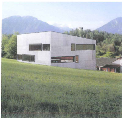
Schoolgebouw in beton te Paspels, Zwitserland. Architect: Aurelio Olgiati
