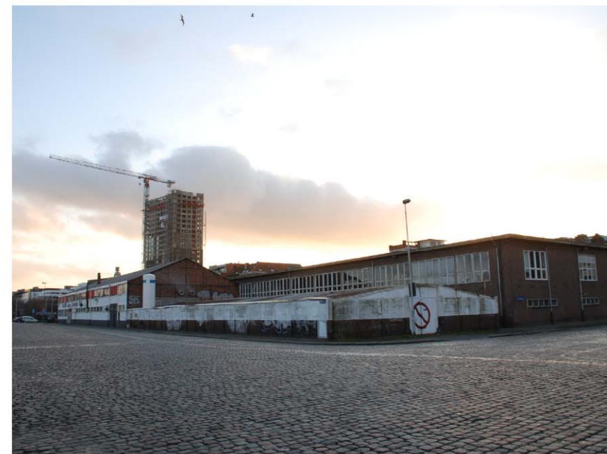
7. Site aan Kempisch dok: deel in gebruik door SISA
