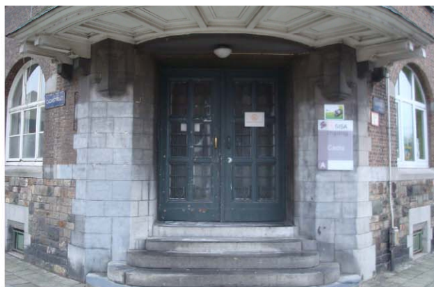
Gevelmaterialen : baksteen, plint van verschillende kleuren natuursteen, details in blauwe hardsteen en smeedijzer (diefijzers, ankers)
