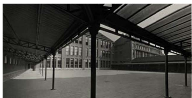
Luilfel speelplaats met vakwerkspanten op typische consoles
