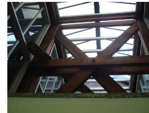
Houten kapconstructie zolders met lichtstraten
