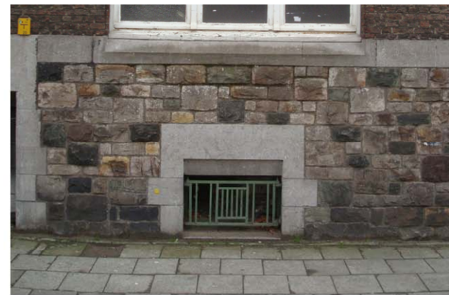
Gevelmaterialen : baksteen, plint van verschillende kleuren natuursteen, details in blauwe hardsteen en smeedijzer (diefijzers, ankers)
