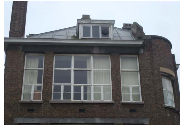
Houten schrijnwerk (combinatie van opendraaiende vleugels en guillotineramen) met oorspronkelijke raampompen
