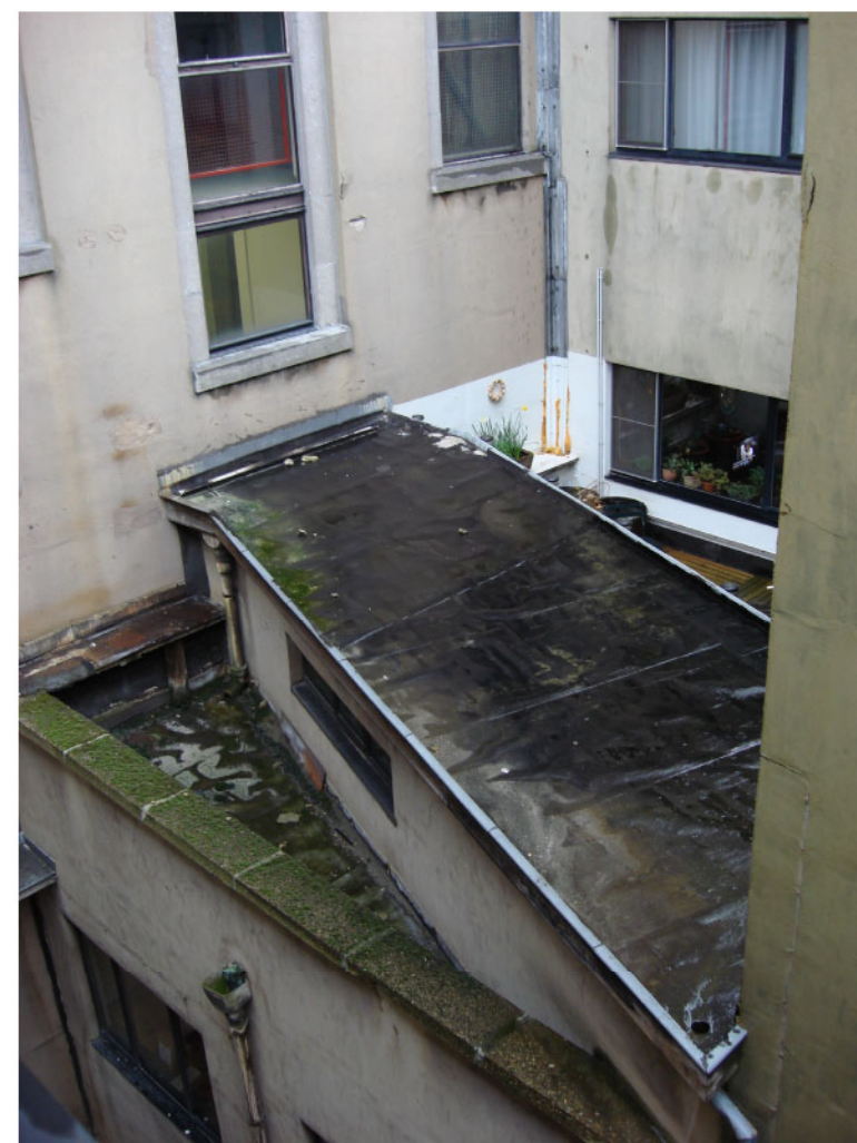
BESTAANDE TOESTAND - ZICHTVANUIT DE HUIDIGE VERBINDING TUSSEN BACKOFFICE EN DE TOREN
