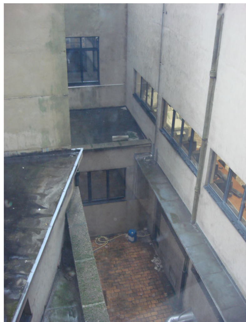
BESTAANDE TOESTAND - ZICHT VANUIT DE TOENTRAP
