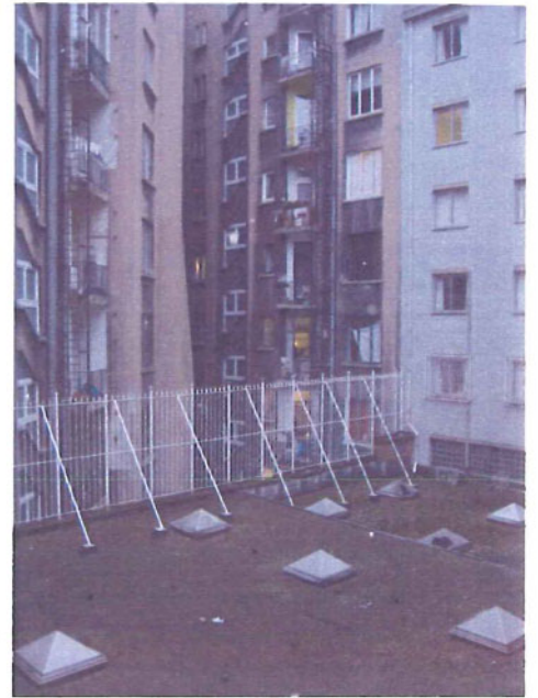
zicht interieur bouwblok
