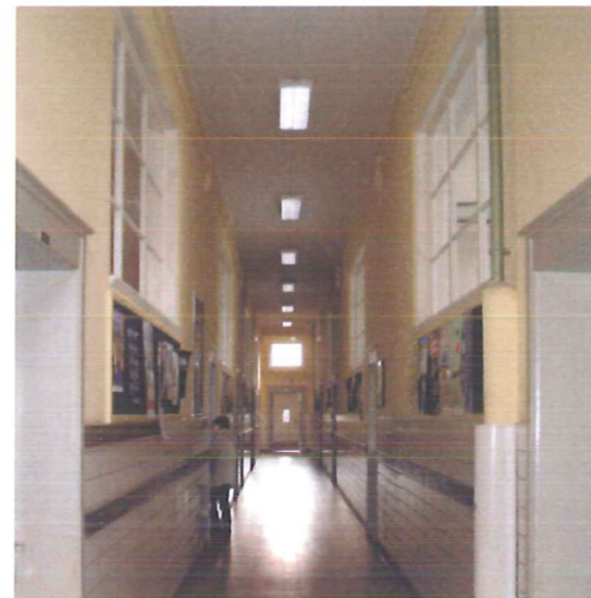
Tegelwanden en vloeren blijven behouden Versleping van kahlän weggewerkt achter het plafond
