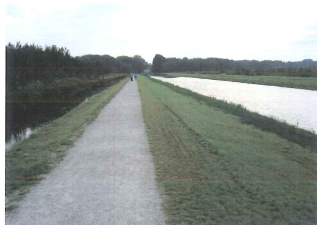
halfverharding voor voetweg (betongranulaat)
