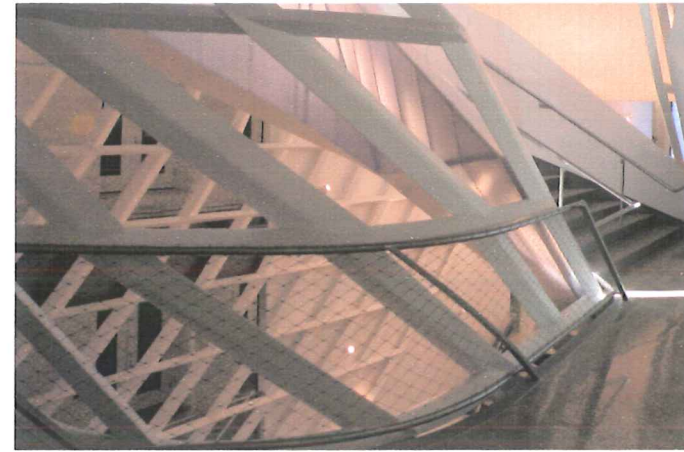
transparante ballustrade uit staaldraad net rond stalen railing
