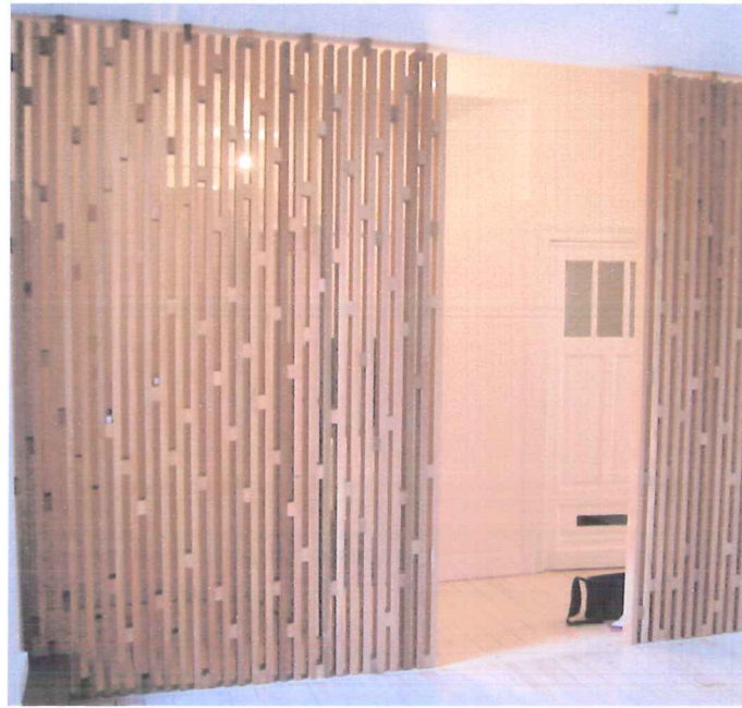
houten scherm opgebouwd uit standaard elementen, snelle en eenvoudige montage.
