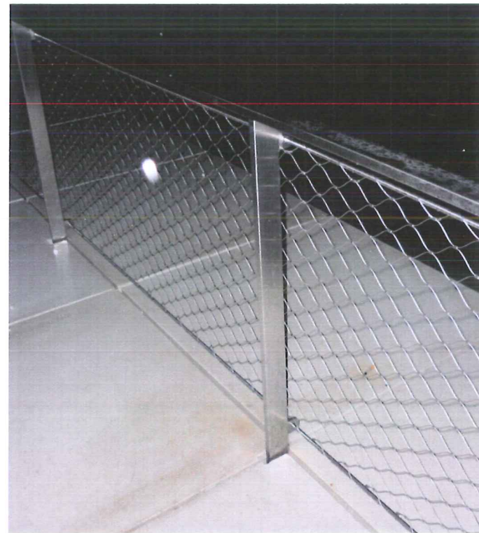
transparante ballustrade uit staaldraad net rond stalen railing
