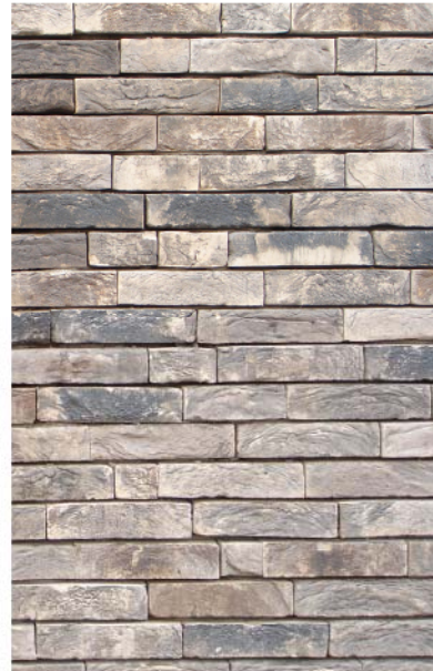
VOORBEELD: GELIJMD METSELWERK
