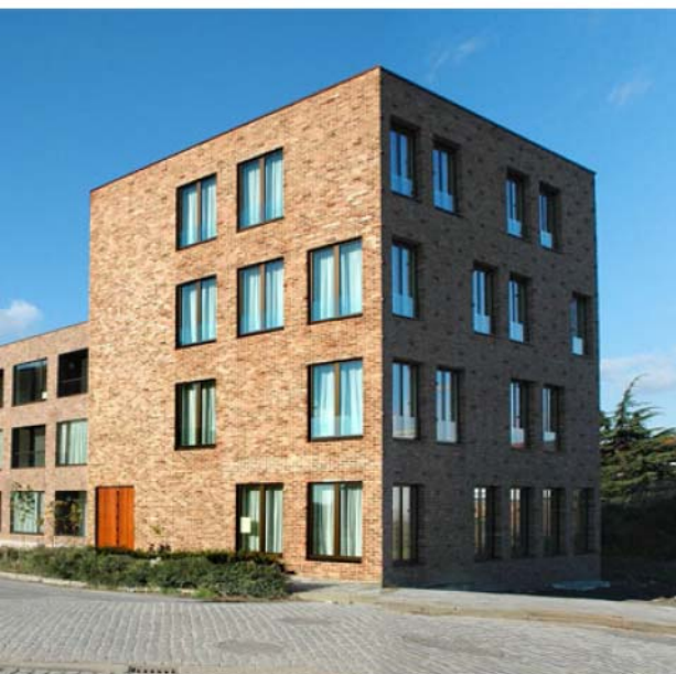
VOORBEELD: VOLUMEWERKING EN GEVEL, NOA
