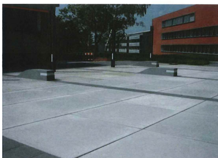
36. gepolierde betonpanelen voor voetgangeras
