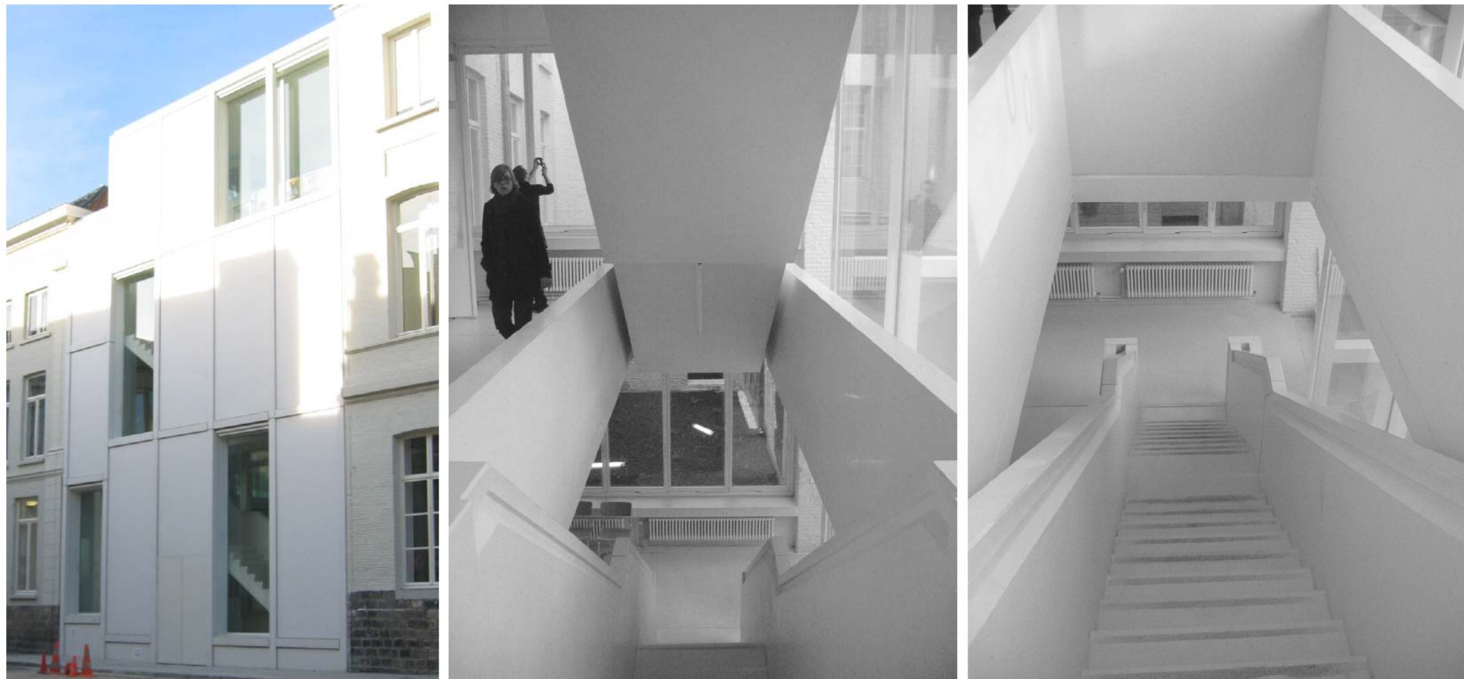
Wit beton, toepassing binnen en buiten - Stadhuis Mene, noA-architecten
