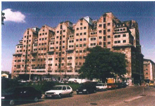
erlwein speicher dresden
