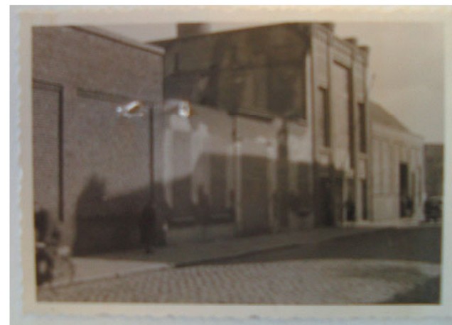
Buurgebouw van hoofdgebouw, zijde Vaartstraat Op de oude foto rechts het vroegere gebouw aan het Werfplein
