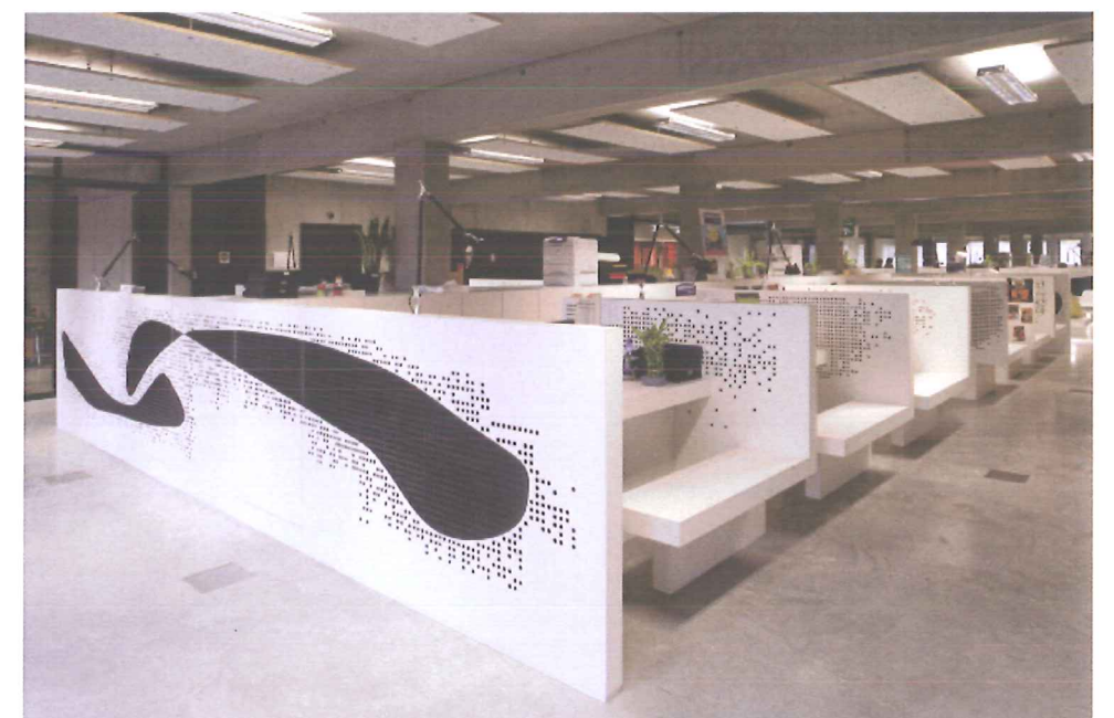
heraklith platen aan plafond als akoestisch baffels - Atlas gebouw te Antwerpen
