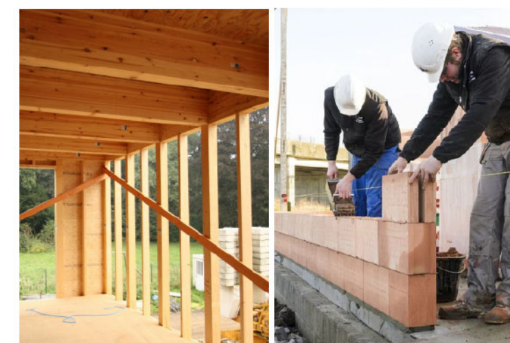
Traditioneel metselwerk naast een houtskeletbouw.
