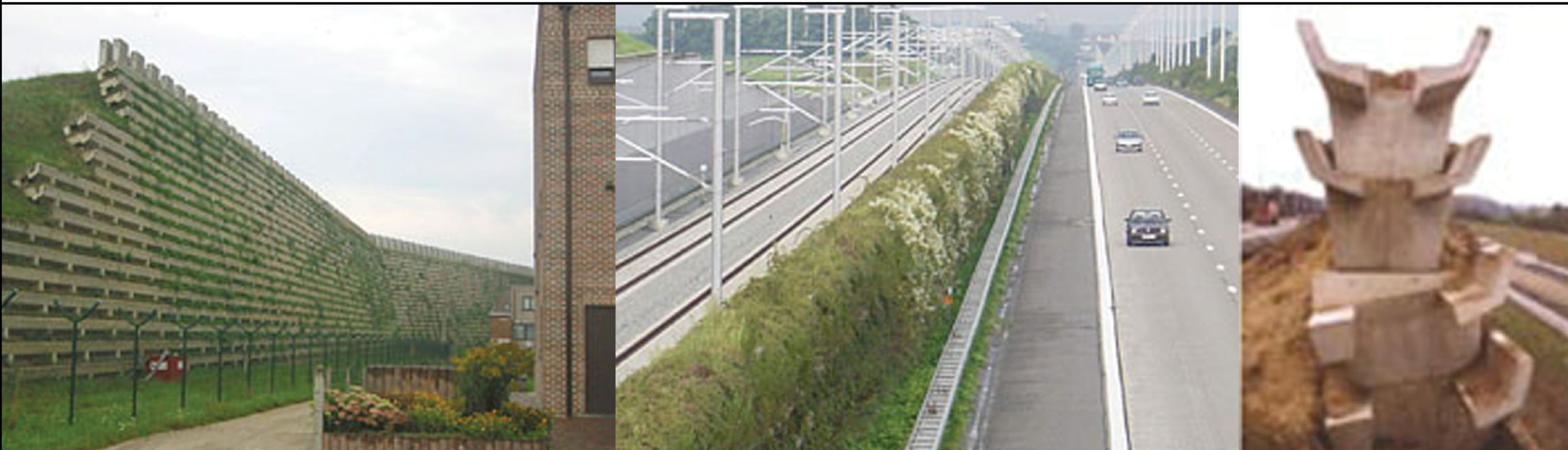
betonnen scherm met beplanting
