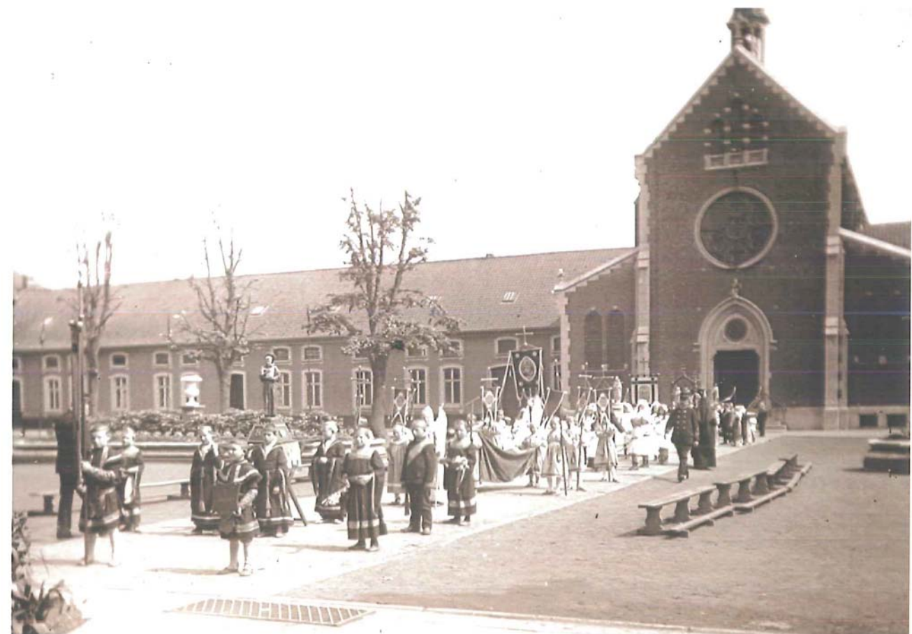
Van kapel tot schoolgebouw De Zande | Ruiselede 09.04.2008
