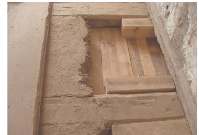
De houten roostering van de vloer wordt ingevuld met leem.
