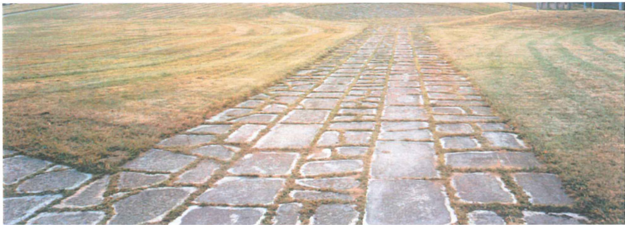
voorbeeld van bestrating aan speelzone >>
