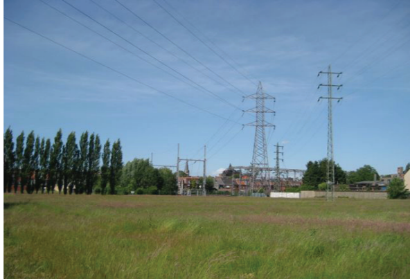
zicht site richting noorden
