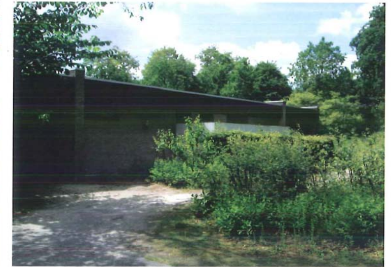
onduidelijke orientatie van de woningen
