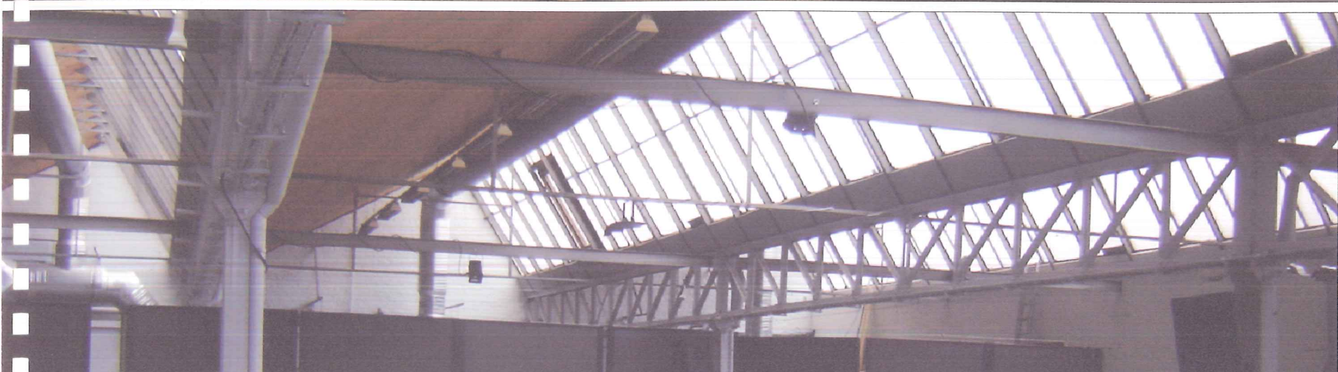
Industrieel gebouw met sheddakstructuur
