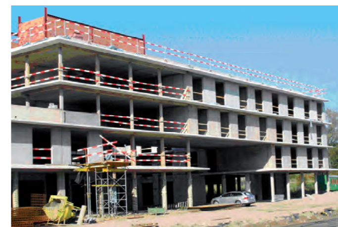
Fig. 5: Referentiefoto project woonzorgcentrum (2008-2009) (Dragende lijnen langs de gevels en de centrale gang, geen interne kolommen)
