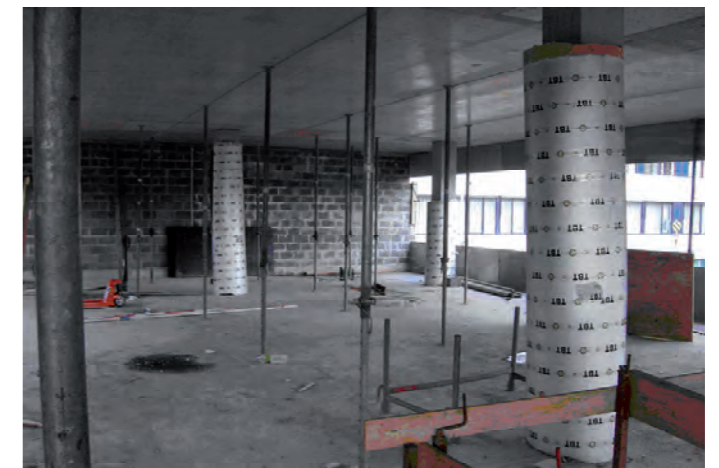
Fig. 6: Referentiefoto project kantoorgebouw (2006-2007) (Betonnen skeletstructuur met grote overspanningen tot 10m)
