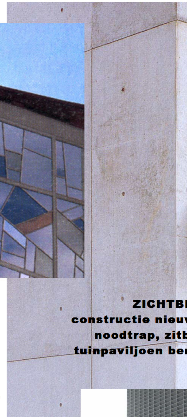
GLAS - gevelbekleding grote vergaderzaal: patchwork klaar en gekleurd glas (cfr glasraam)
