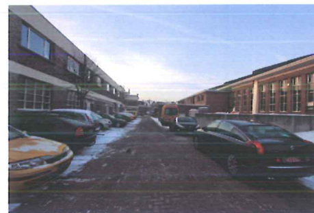
VOORPLEIN: 'DODE' GEVEL BIJGEBOUW
