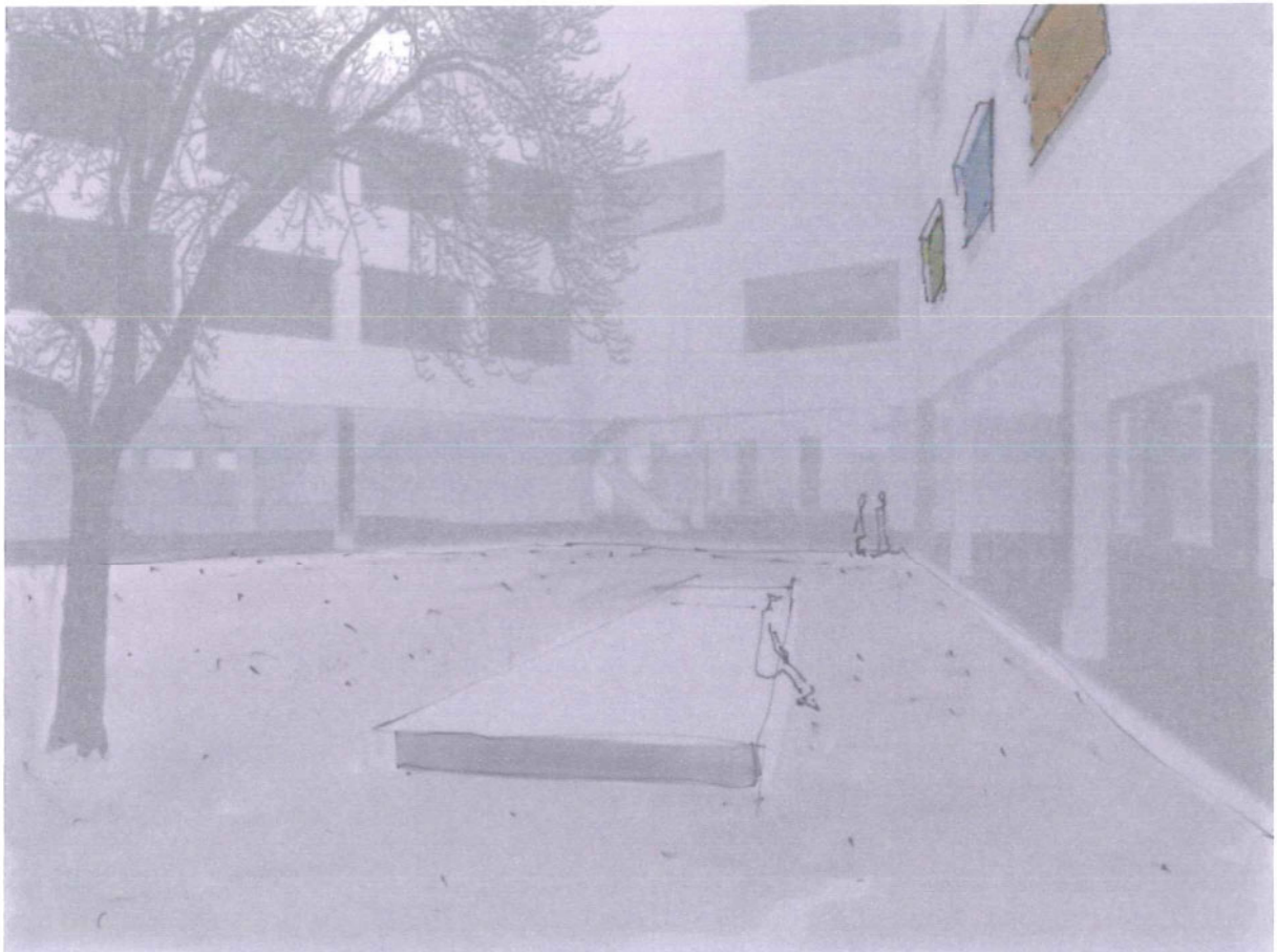
Zicht op de central hal vanaf de tuinzijde
