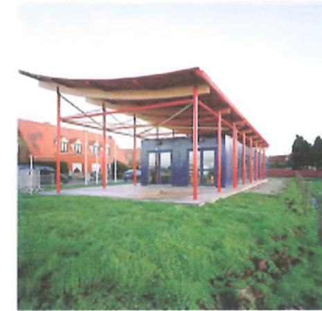
De Meeuw, containers - luifel als overgang tussen binnen en buitenruimte.
