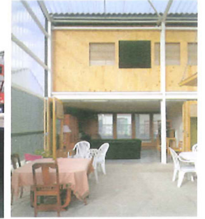
Floriac, woning Lapatie, arch. Lacaton en Vassal, een overschot aan ruimte...
