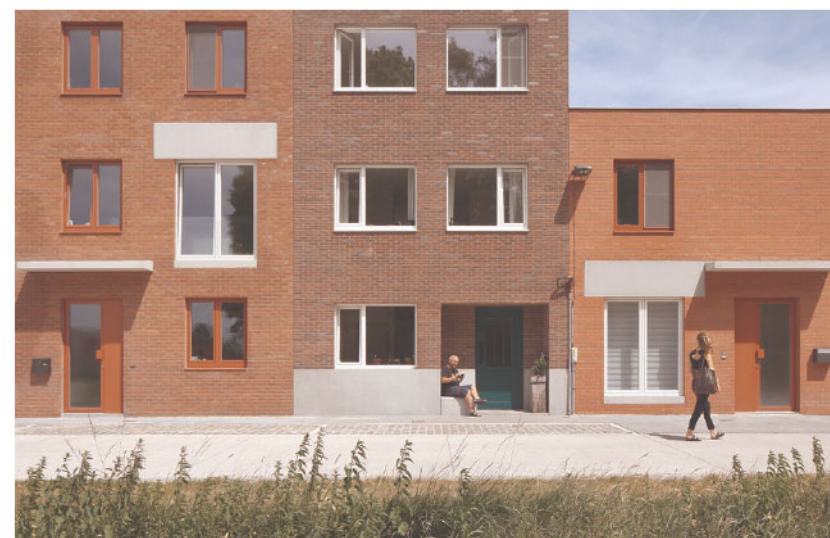
Referentie centrumsite: Luifels en nissen markeren de inkom als plek voor ontmoeting, plinten en lintelen maken de woningen herkenbaar (ECTV architecten en Bart Dehaene)
