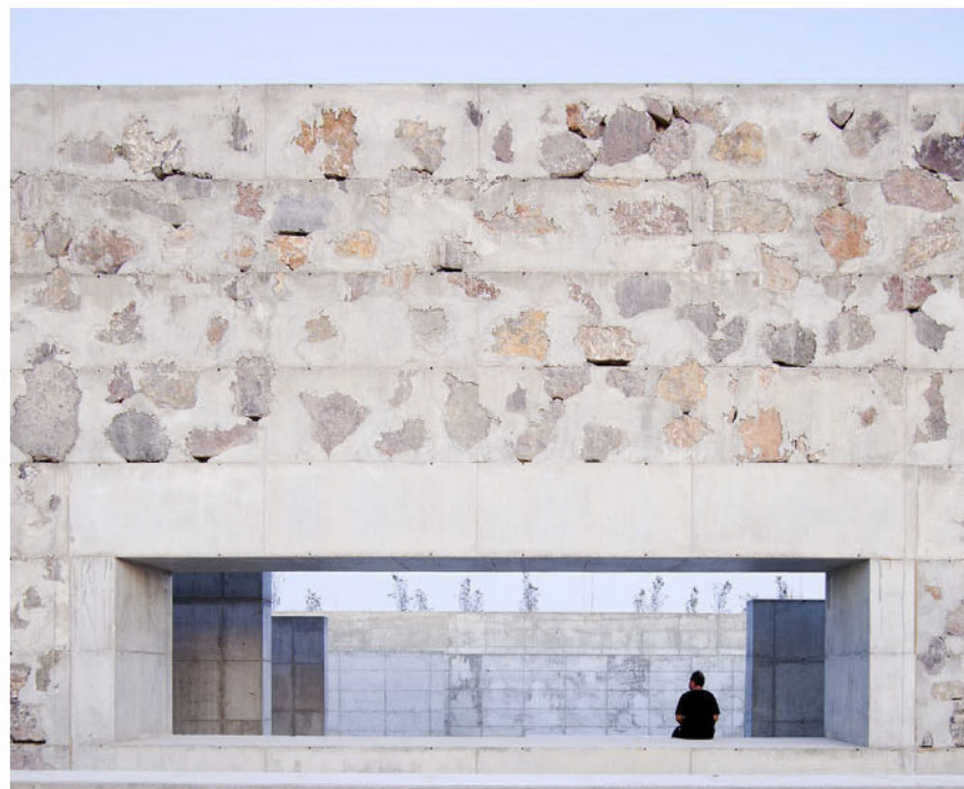
cyclopisch beton - Parque Valdefierro, Héctor Fernandez Elorza
