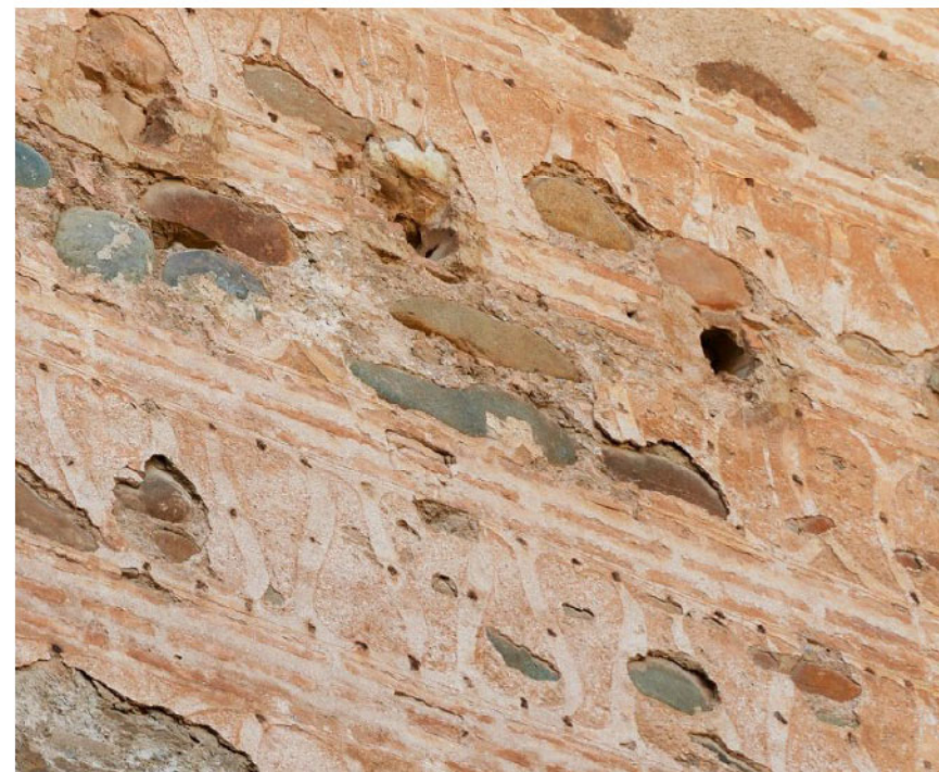
cyclopisch beton gemengd met aarde en steen
