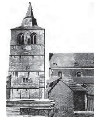
Verplaatsing toren St.-Laurentius kerk - 1910
