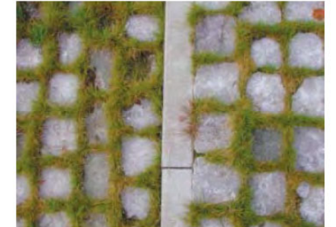
Verharding plein - tegels met grasvoeg
