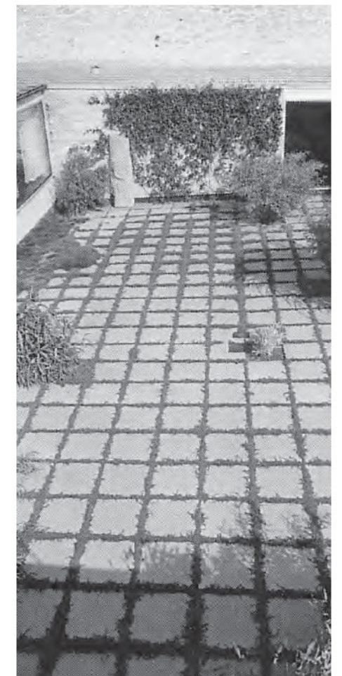
Verharding plein - tegels met grasvoeg
