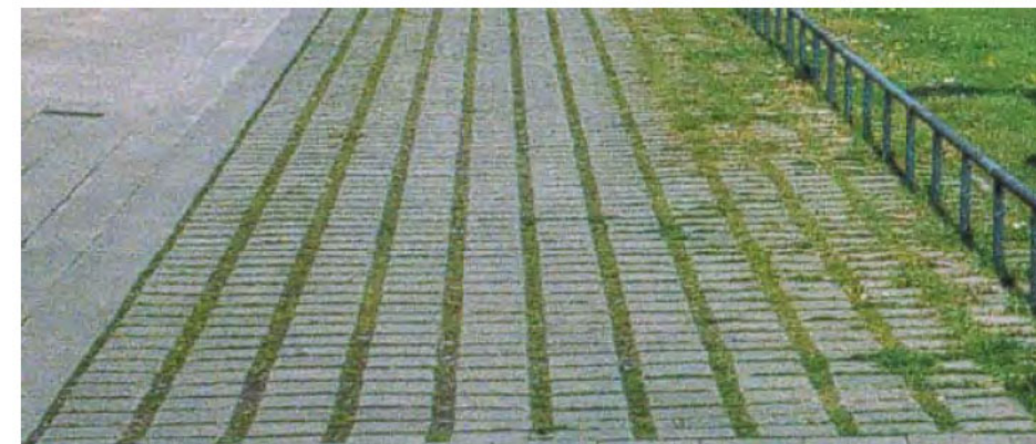
Verharding plein - tegels met grasvoeg
