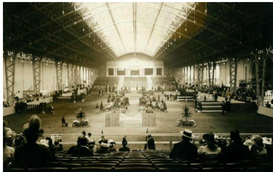
Algemeen zicht op de spantenconstructie van de grote serre tijdens een Jumping, 1913
