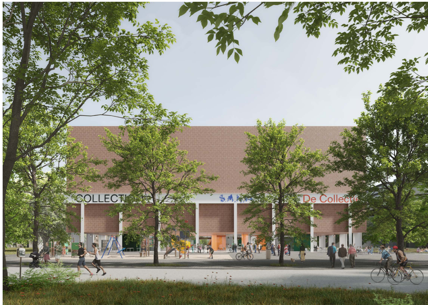
Collectiehuis - De hoogte van het gelijkvloers is bewust lager dan dat van de S.M.A.K.Hal, en creëert een intimiteit voor de functies gelegen op het gelijkvloers.
