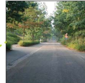
Centrale as doorheen het gebied
