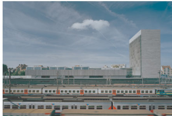
Provinciehuis Leuven - Gonçalo Byrne & Wit Architecten. Een groot maar geleed gebouw, ongeveer dezelfde voetafdruk als het project 'Kanaalbocht'.
