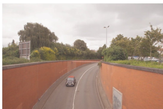
Ondertunneling spoor voor doorstroming
