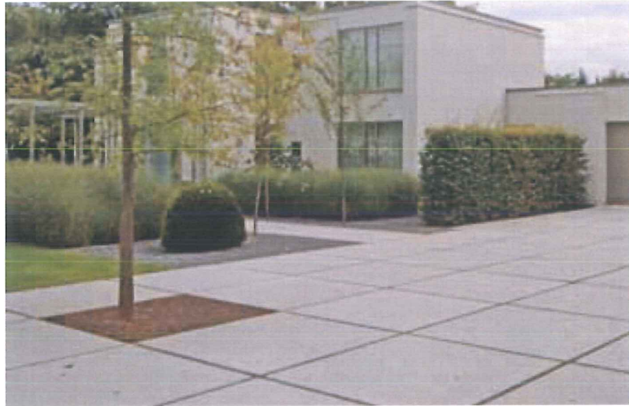
Referentie: stelcon-platen
