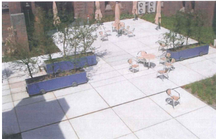
Referentie: stelcon-platen
