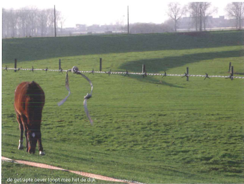
de getrapte oever loopt mee het de dijk
