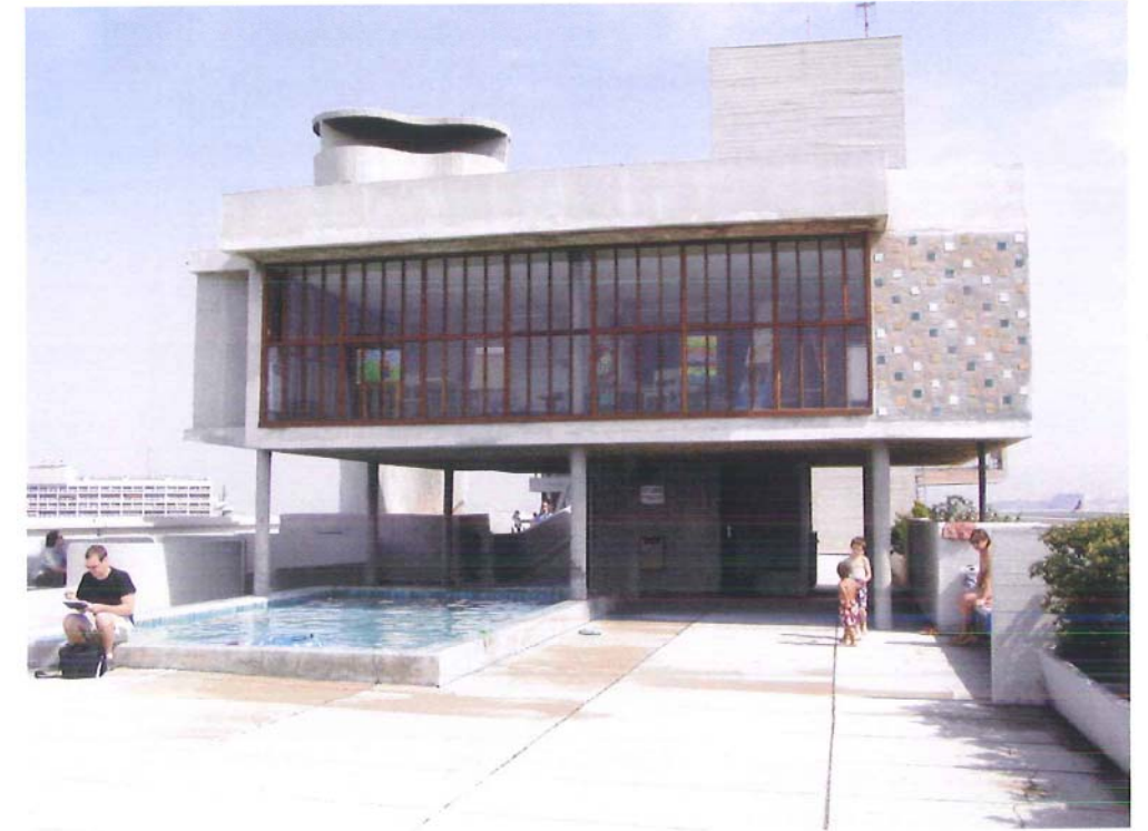
Le Corbusier, Unité Habitation crèche, Marseille
