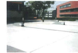
betonplaten voor binnenkoer
