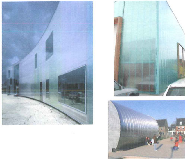
gevelbekleding circulatieruimte : polycarbonaatplaten
