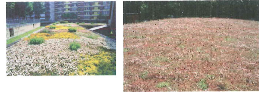
dakbedekking : groendaken, een extensieve begroeiing met sedumbeplanting
