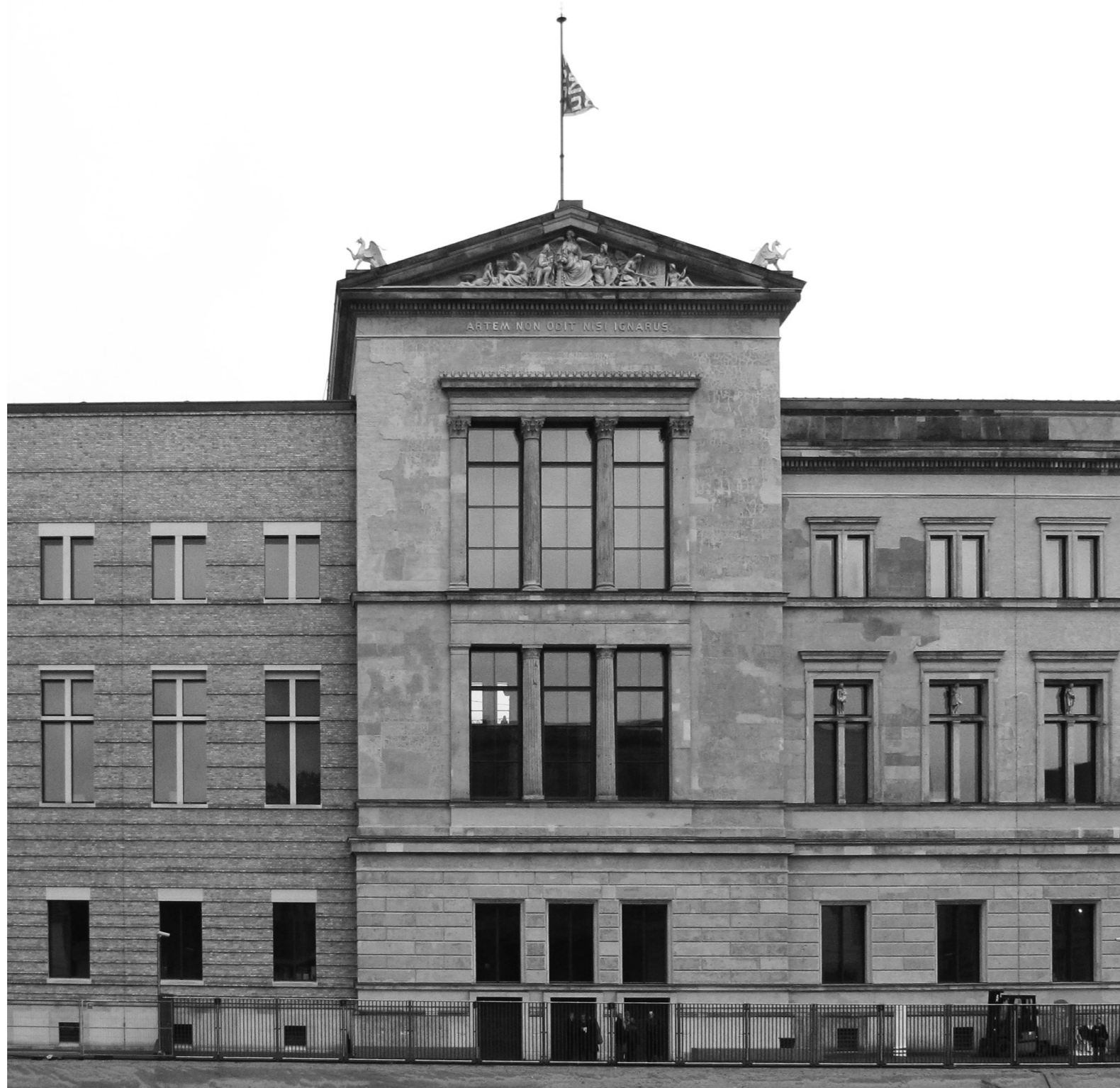
referentieproject Neues Museum Berlin, David Chipperfield Architects, 1995- 2009, verloren geveldeel wordt op abstractie manier hersteld
