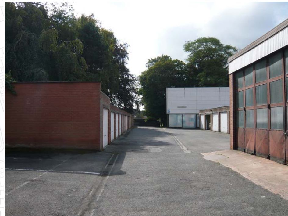
Site Jonkhove—intek ter hoogte van sporthal
