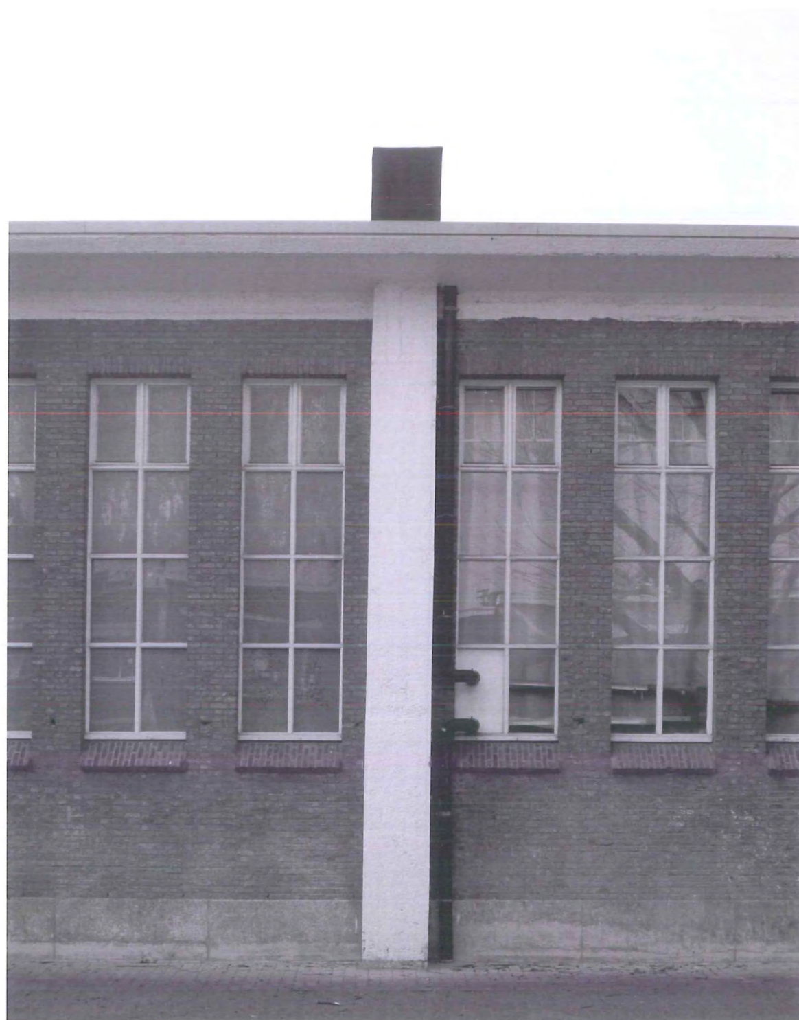
gevel hal 3 - bestaand
