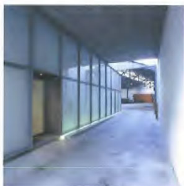
BACOB-gebouw te Dendermonde (detail van het glazen vlies met transparante en heldere beglazing)
