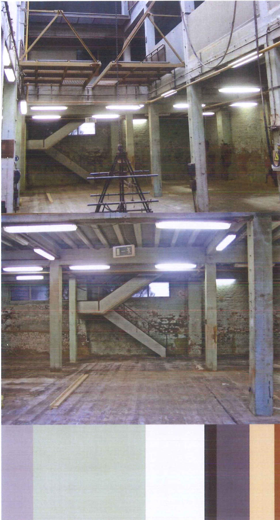
kleuranalyse 3 interieur bestaande gebouw
