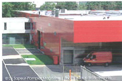
brandweerkazerne de Bruges-Bordeaux-France
