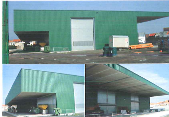
groen gecoate geprofileerde staalplaat (Bulk architecten)
